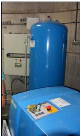
Figure 14. Vue de la chambre de commande – Panneau de contrôle pneumatique, compresseur et réservoir
