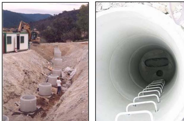
Figure 4. Tranchée et regard pour drains siphons – RN200
