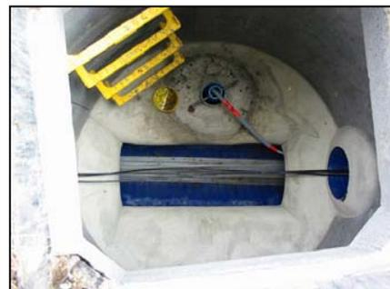
Figure 11. Regard équipé en drain siphon
