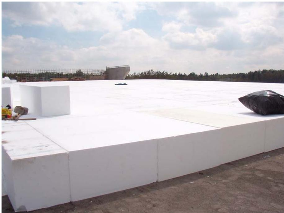
Figure 5 : Vue rapprochée d'une couche de polystyrène
