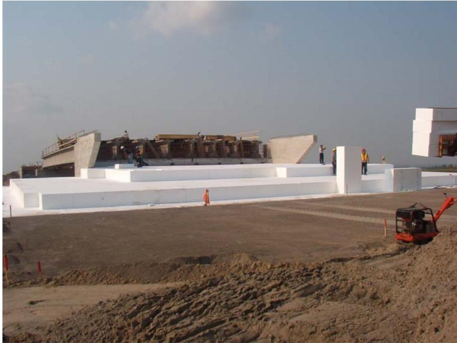
Figure 4 : Mise en place des blocs de polystyrène
