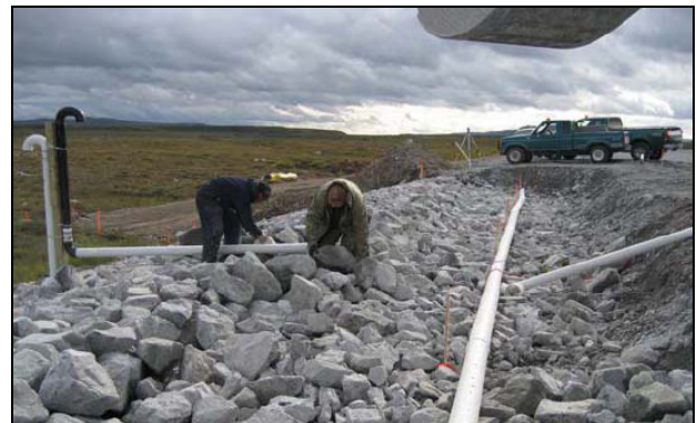
Figure 2. Installation du système de ventilation dans le remblai à convection d'air
