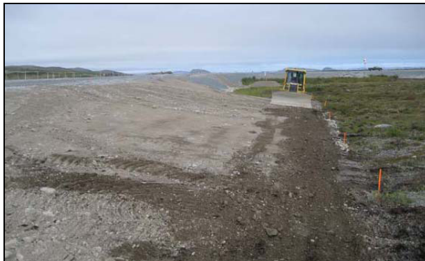
Figure 1. Construction du remblai à pente douce
