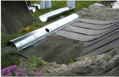
Figure 3: Drain thermique bien installé
