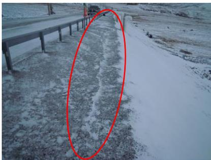
Figure 14: Fissure longitudinale avec décrochement située près des inclinomètres de la station B
