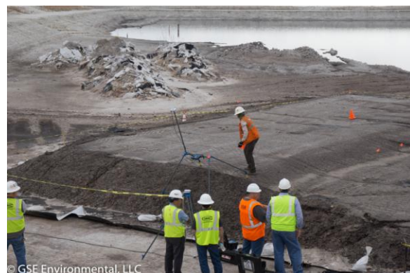
Figures 5-7. Simple test pad construction
